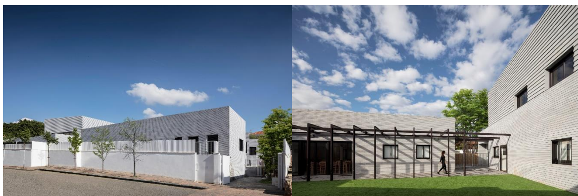
Figura 7 – Fachada externa e fachada interna.
