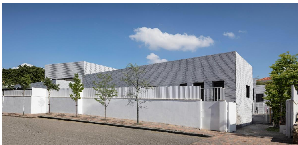
Figura 4 – Fachada secundária do abrigo.
