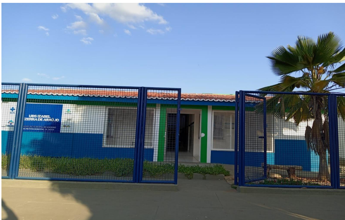
Foto 1 – Foto da UBS Izabel Bezerra de Araújo localizado na comunidade do Jucuri na cidade de Mossoró/RN. Registro feito pela autora.
