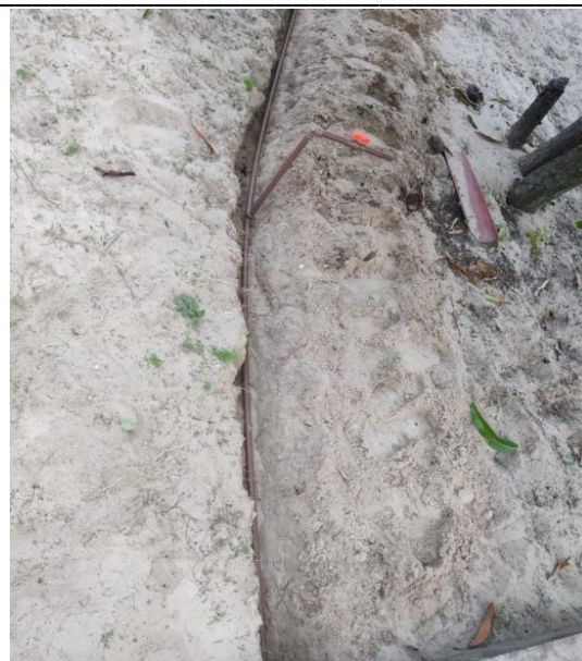
Figura 6: Instalação dos registros direcionados para cada planta. Fonte: Autoria própria (2025).
