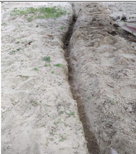
Figura 4: Processo de abertura da valeta. Fonte: Autoria própria (2025).
