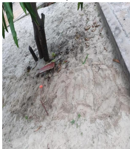
Figura 7: Reposição da areia nas valetas, cobrindo os canos para proteção. Fonte: Autoria própria (2025)
