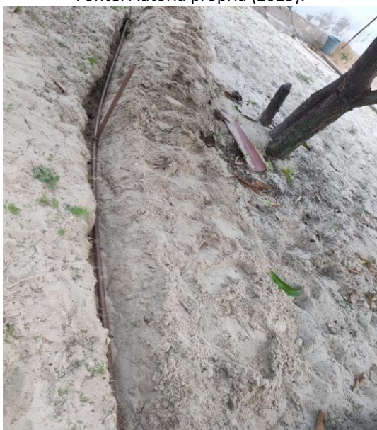
Figura 5: Posicionamento dos canos para instalação do sistema de irrigação. Fonte: Autoria própria (2025).
