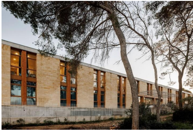
Figura 12 - Vista da fachada.
