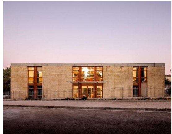
Figura 13 - Vista da fachada.
