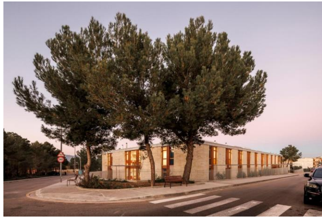
Figura 10 - Vista da Residência para idosos em Pòrtol.
