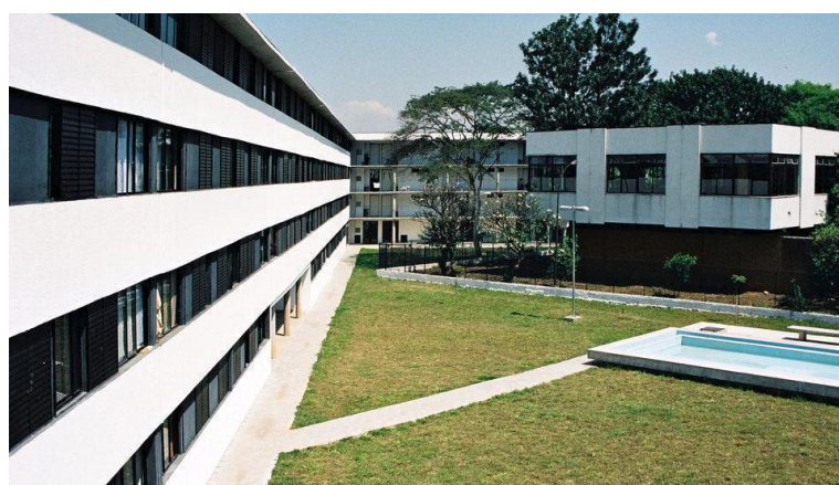
Figura 3 - Área externa da Vila dos Idosos.
