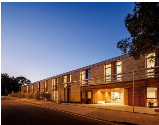
Figura 18 - Vista da fachada.
