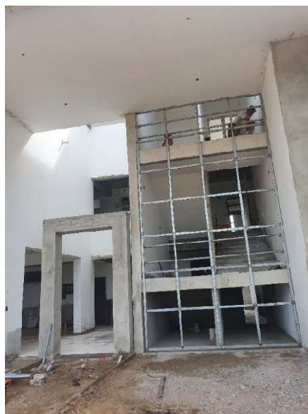
Figura 7 – Instalação de vidros nas esquadrias. (Autoria própria).
