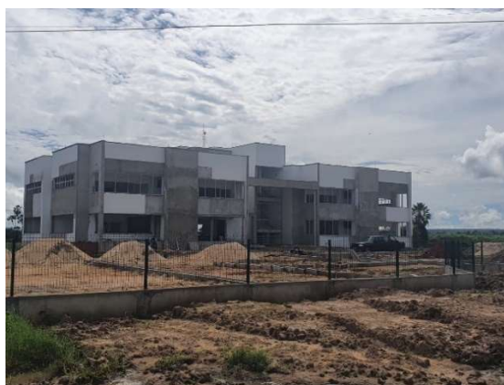
Figura 2- Construção do Centro de Educação Infantil. Autoria própria.
