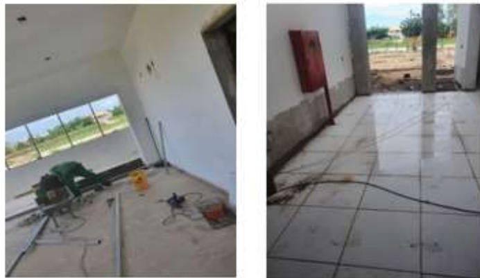
Figura 6– Aplicação de revestimento cerâmico e exposição de fios. (Autoria própria).
