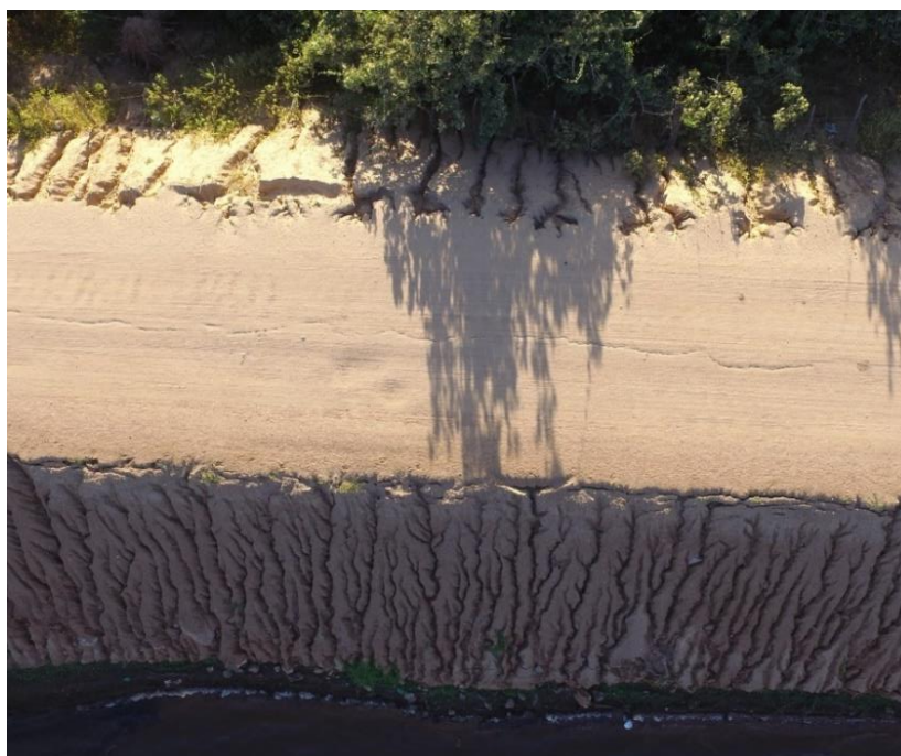
Figura 26 - Rachadura longitudinal
