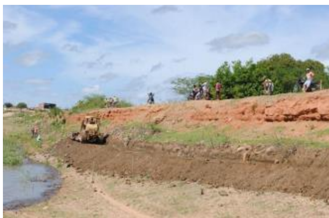
Figura 29 - Registro da ampliação da barragem
