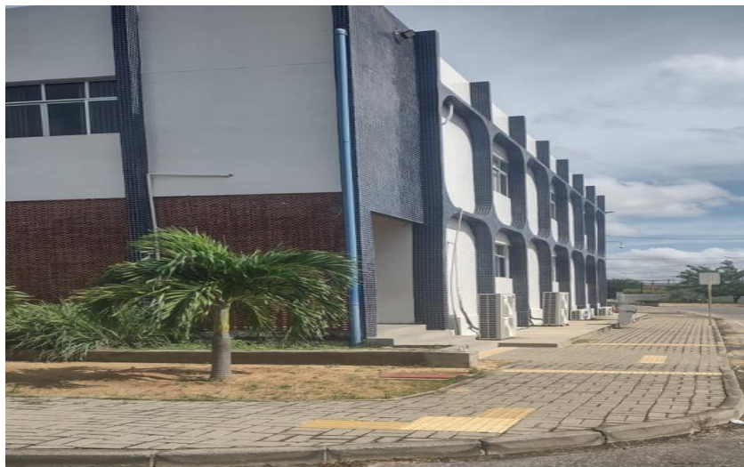
Figura 1 - Blocos para pavimentos intertravados utilizados em calçamento da UFERSA.
