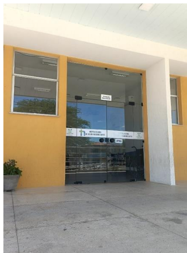
Figura 4 - Porta de entrada principal.
