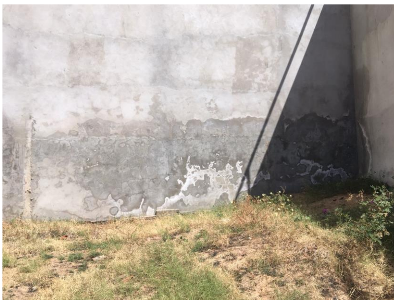
Figura 17 - Mancha do tipo mapeada
