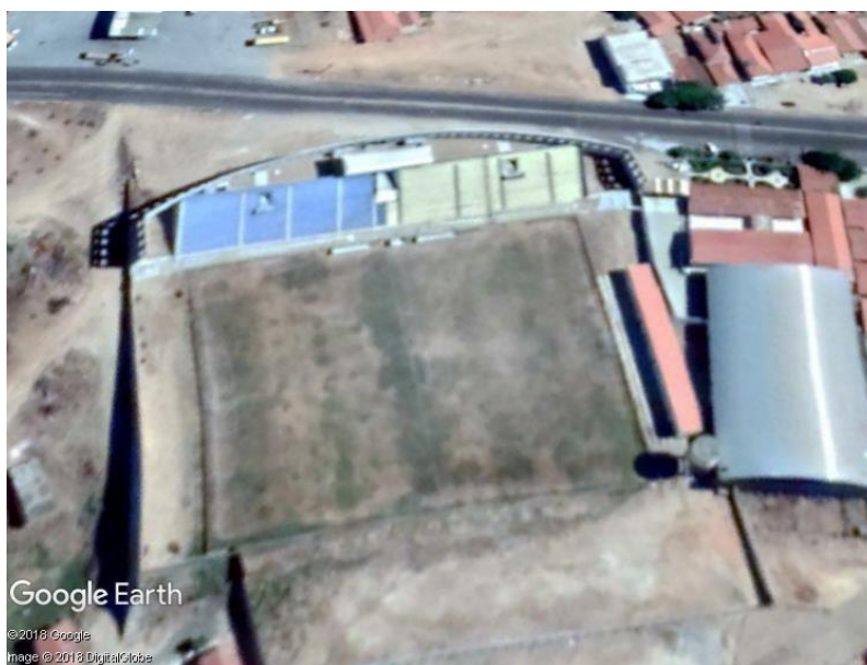
Figura 5 - Imagem aérea da Arena Coliseu Fonte: Google Earth (2018)
