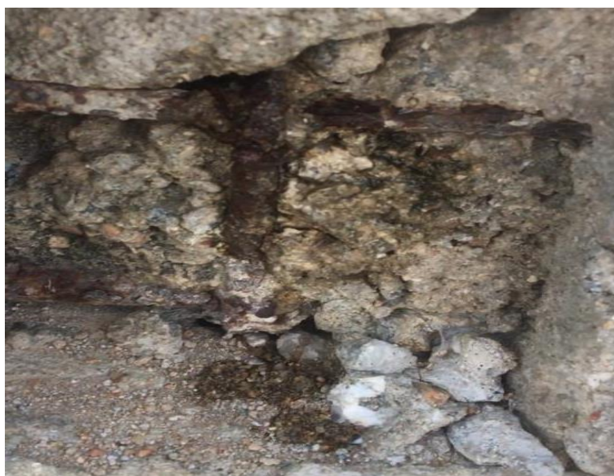
Figura 21 - Região exposta ao meio, durante aplicação de Fenolftalína 1%
