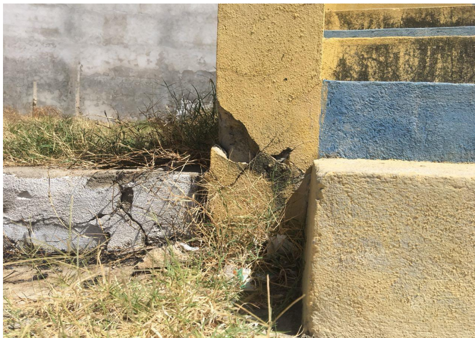
Figura 19 - Base da arquibancada
