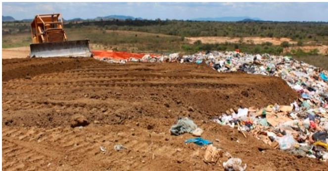
Figura 06: Cobertura e compactação dos resíduos.
