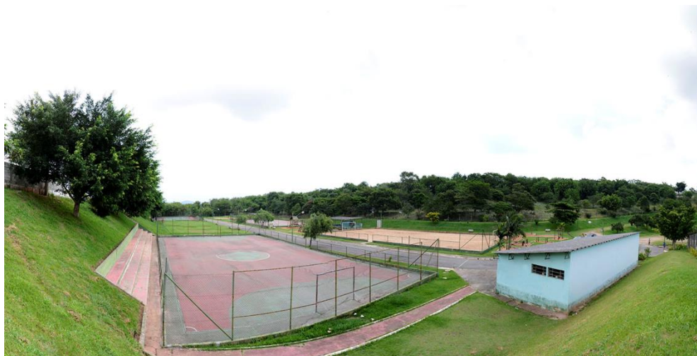
Figura 09: Parque das Orquídeas (antigo aterro sanitário).
