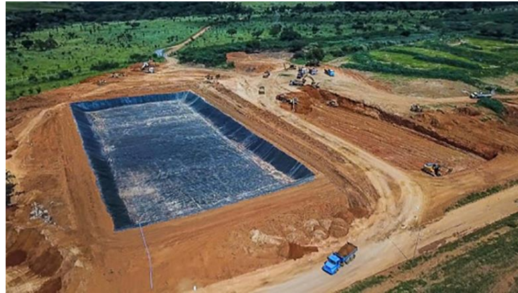
Figura 05: Construção de aterro sanitário.
