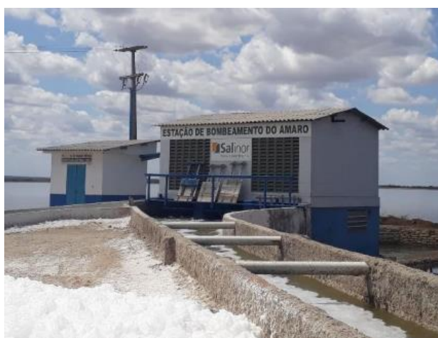
Figura 5 - Estação de bombeamento do Amaro.
