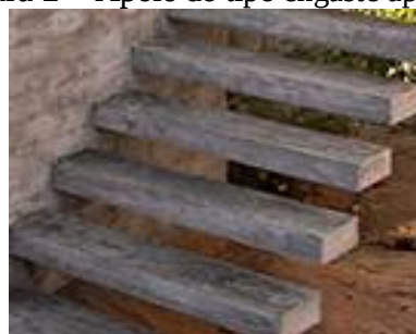
Figura 2 – Apoio do tipo engaste aplicado
