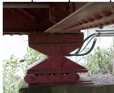
Figura 6 – Apoio do tipo rolete aplicado
