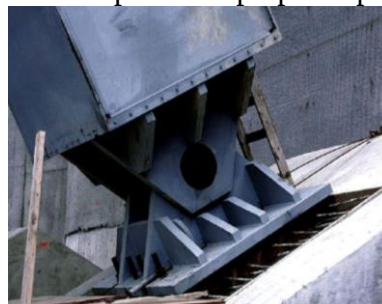
Figura 4 – Apoio do tipo pino aplicado
