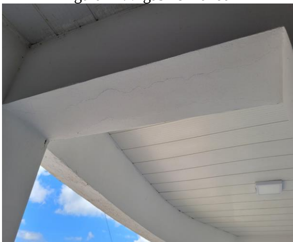
Figura 12: Vigas no 2 andar
