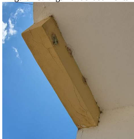
Figura 13: Viga na fachada frontal
