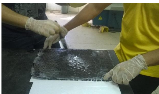
Figura 8- Laminação de fibra de carbono
