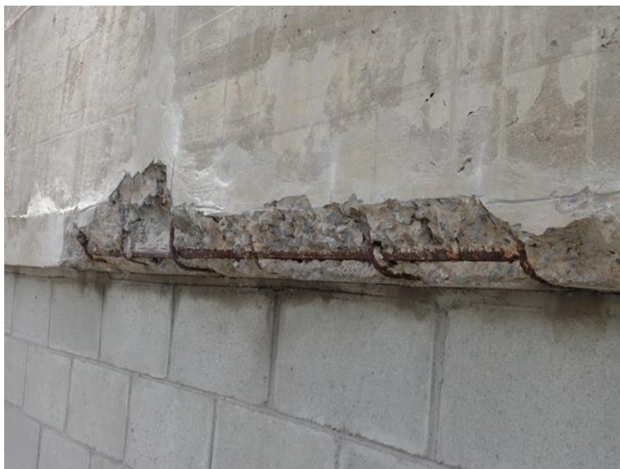
Figura 5: Corrosão
