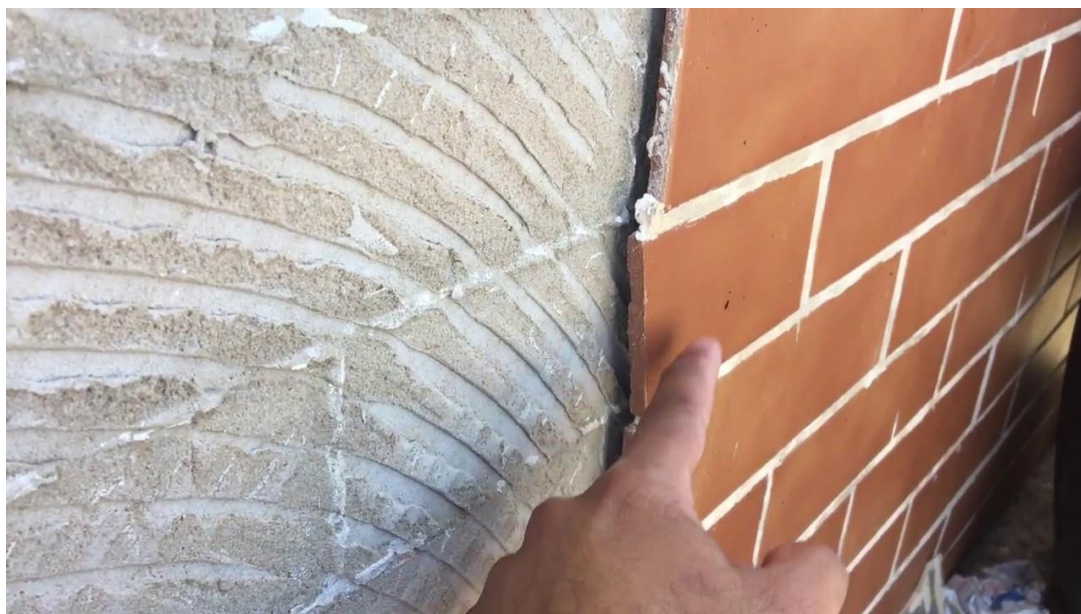
Figura 6: Desplacamento cerâmico
