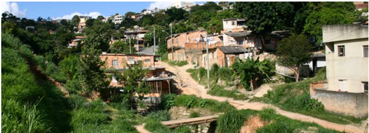
Figura 9 – DRENURBS, Belo Horizonte, antes da intervenção.
