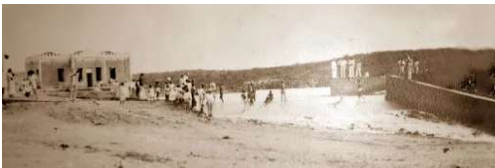
Figura 30 – Parede do Açude Velho, Salgueiro-PE.
