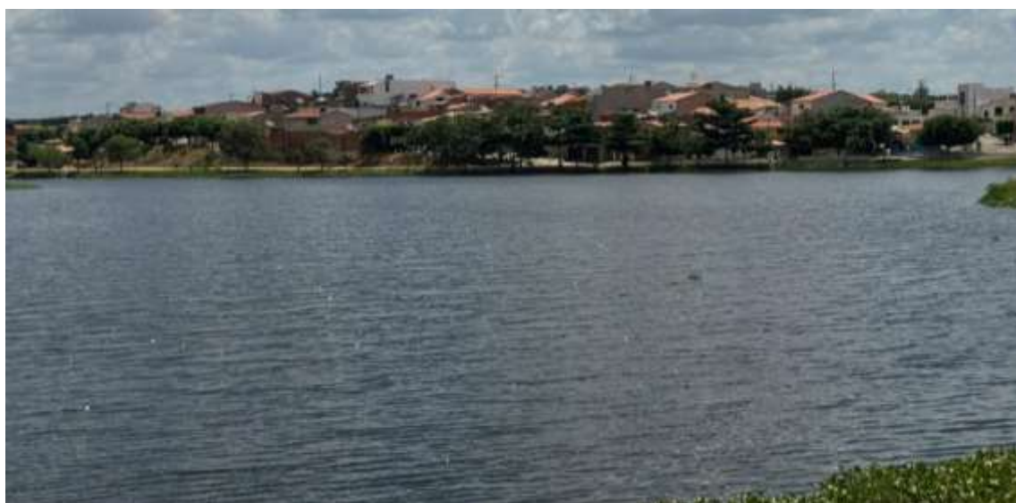
Figura 45 – Açude Velho, Salgueiro-PE.
