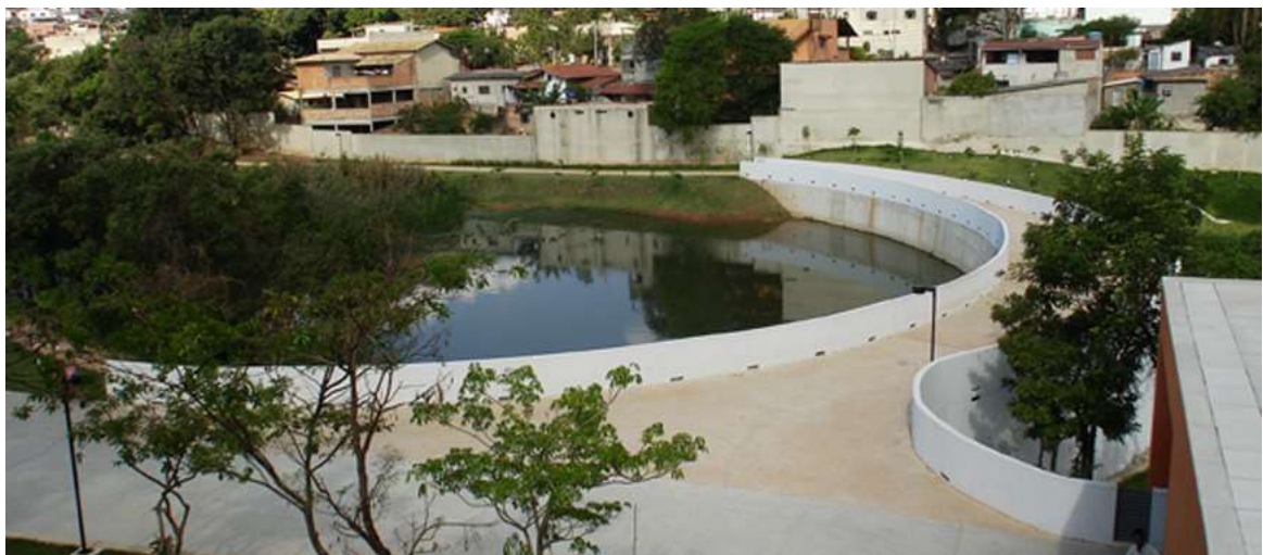
Figura 10 – DRENURBS, Belo Horizonte, após a intervenção.
