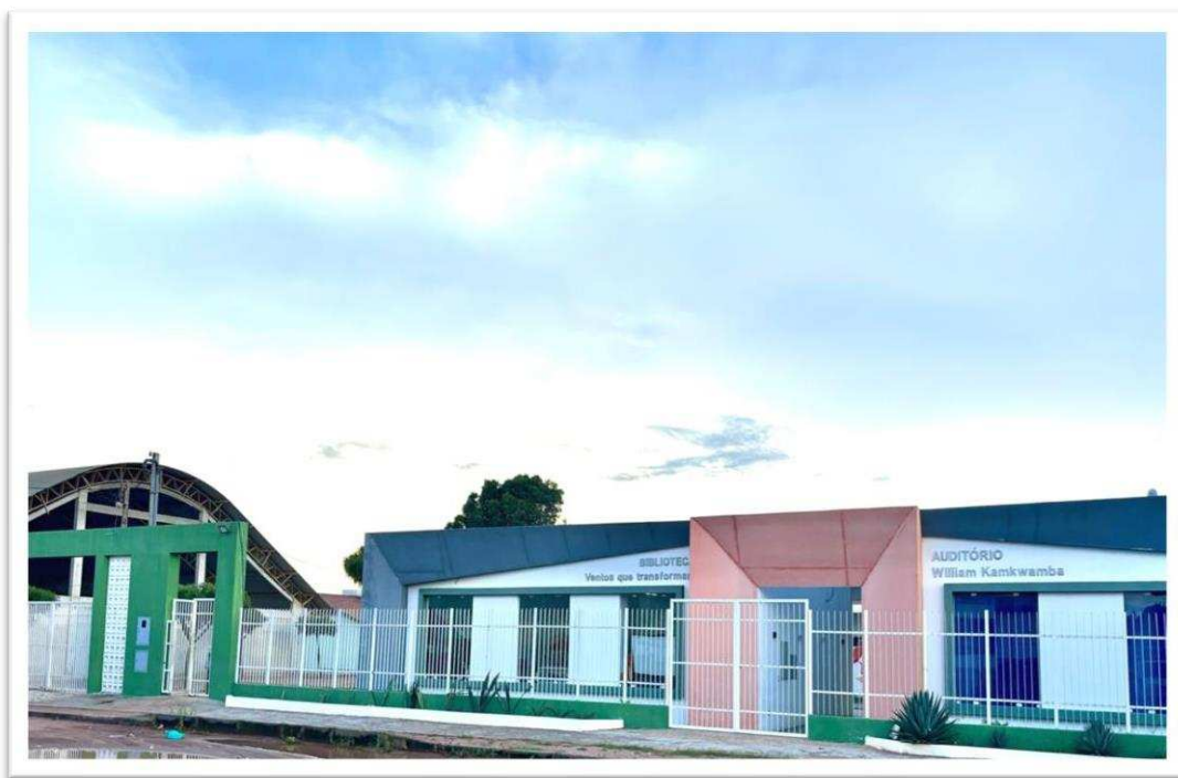
Figura 1 – Fachada da Escola Estadual Padre José Anchieta
