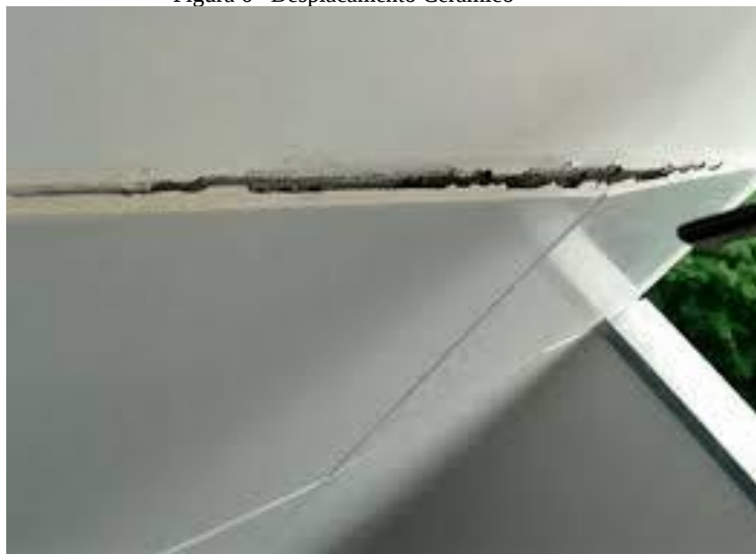
Figura 6– Desplacamento Cerâmico
