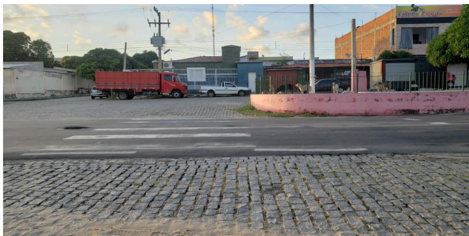
Figura 23 - Local de aplicação trecho 2
