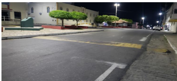
Figura 11 - Fotografia do Local de aplicação trecho 1
