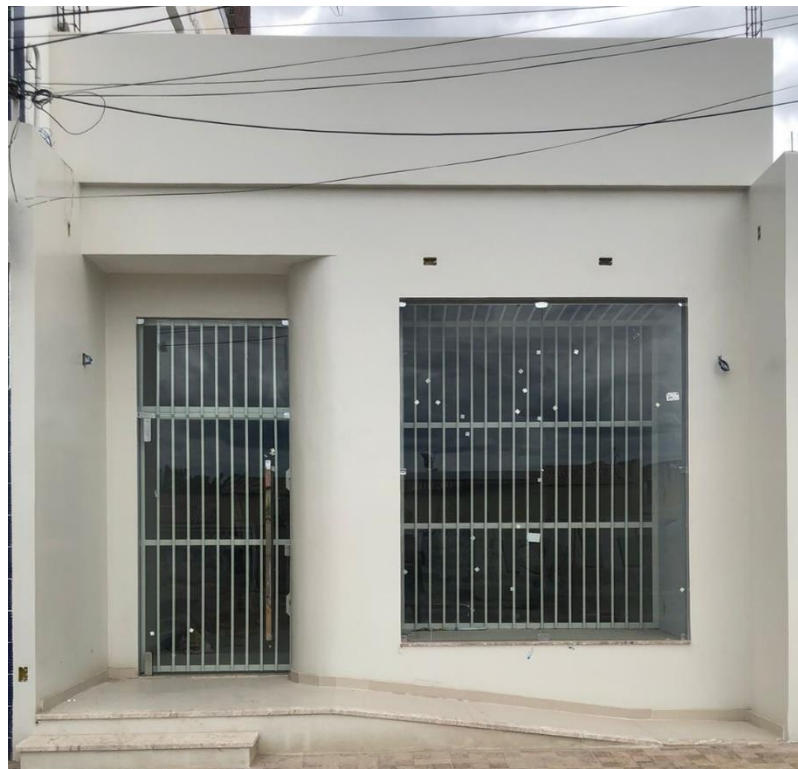
Figura 17: Fachada principal executada parcialmente
