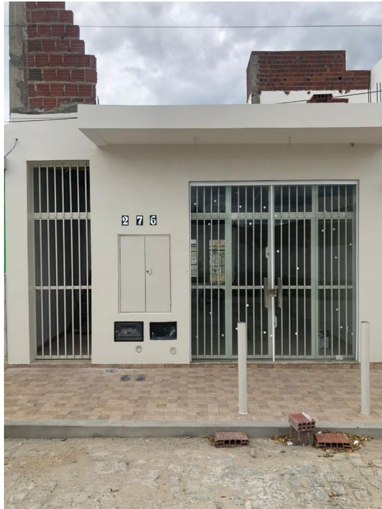
Figura 18: Fachada posterior executada parcialmente
