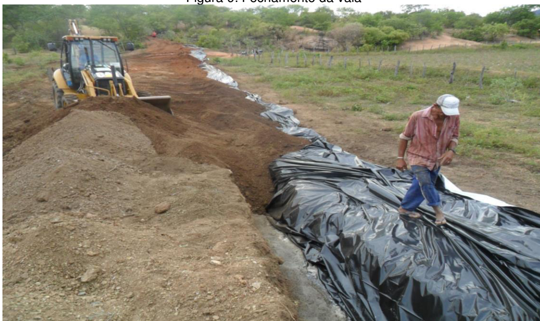
Figura 9: Fechamento da vala
