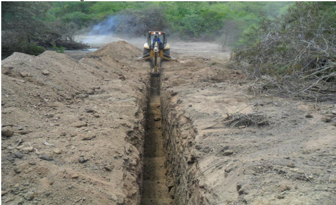
Figura 5: Abertura da vala utilizando retroescavadeira
