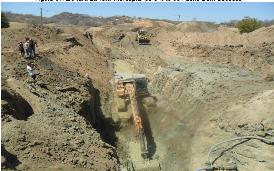
Figura 6: Abertura da vala interceptando o leito do riacho Bom Sucesso
