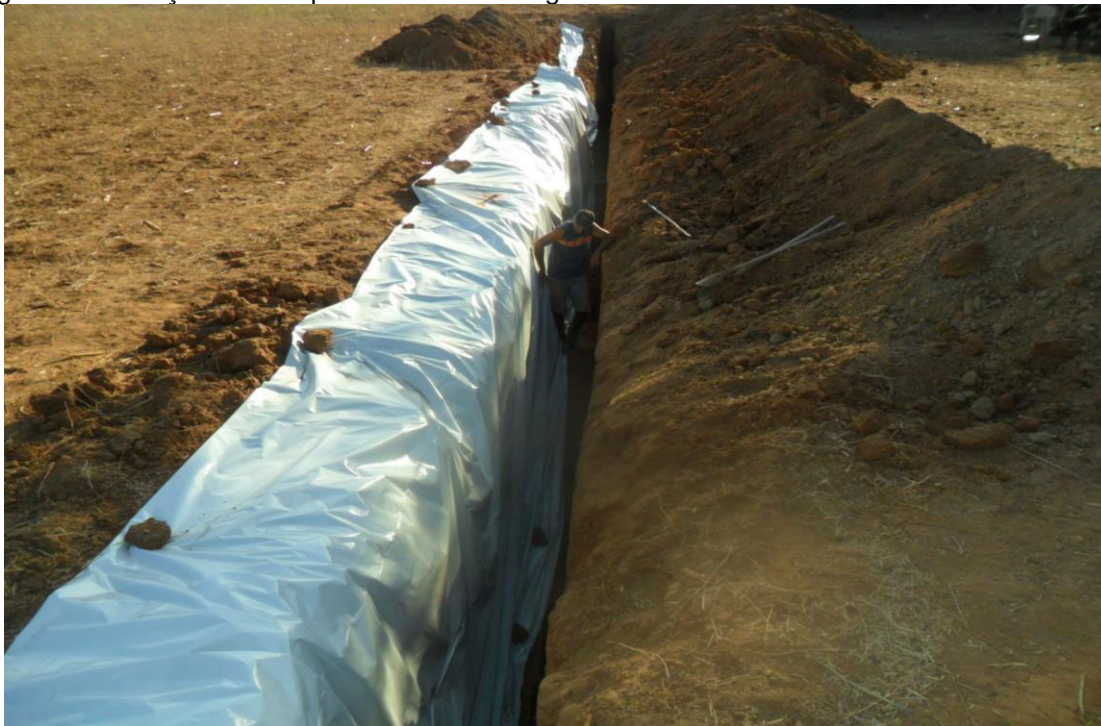
Figura 8: Instalação da lona plástica numa barragem subterrânea construída em Bom Sucesso/PB
