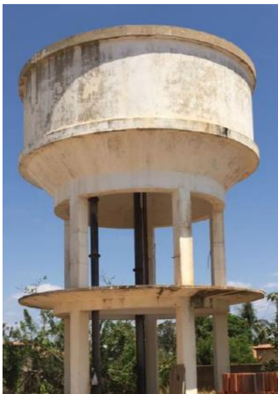
Figura 3 - Reservatório de Caraúbas em funcionamento.
