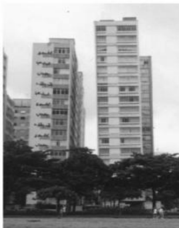
Figura 5 – Exmplo de Recalque de fundações em edifício de Santos/SP.
