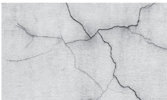
Figura 3 – Parede Fissurada
