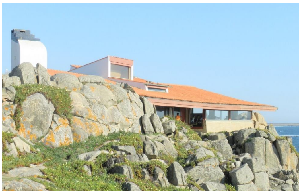
Figura 23: Vista lateral da Casa do Chá Boa Nova.
