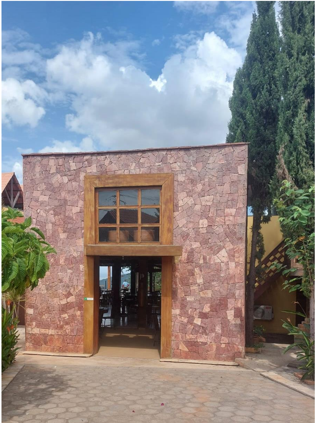
Figura 43: Aplicação da pedra vermelha como revestimento em alvenaria.
