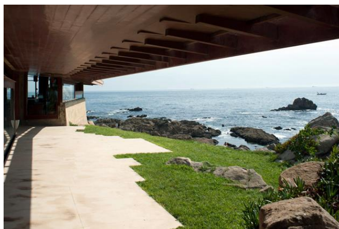
Figura 25: Saída do edifício para as rochas existentes no local
