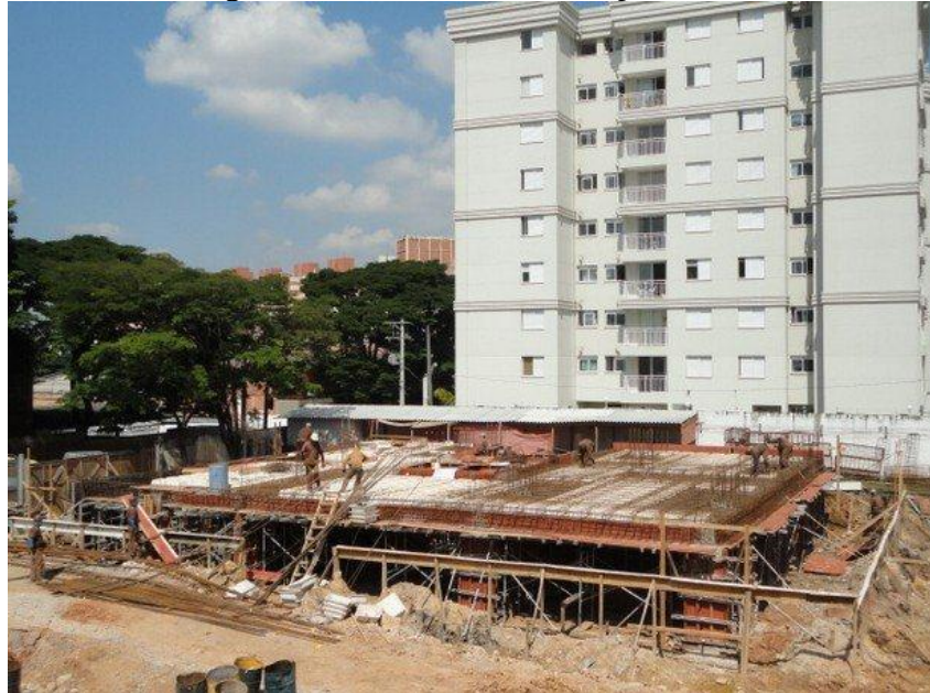
Figura 1: Canteiro de obras do tipo restrito
