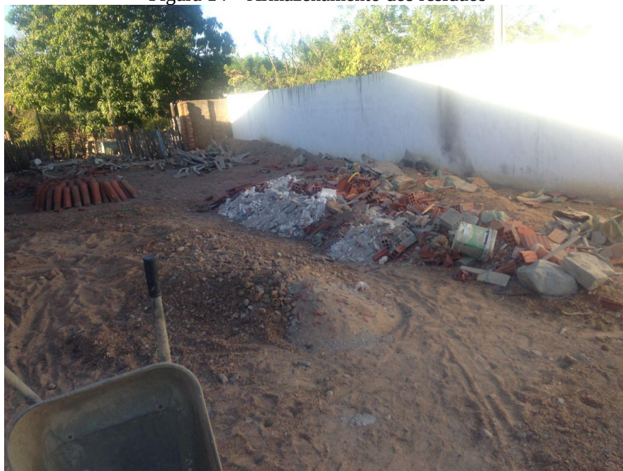
Figura 14 – Armazenamento dos resíduos
