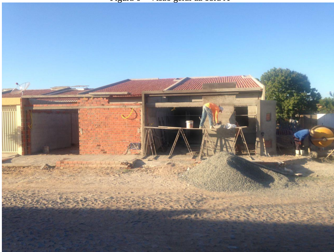
Figura 6 – Visão geral da obra A
