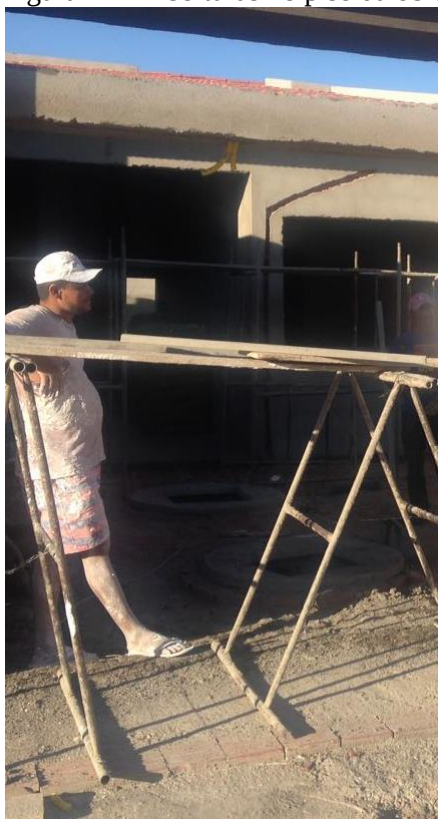
Figura 11 – Aberturas no piso da obra
