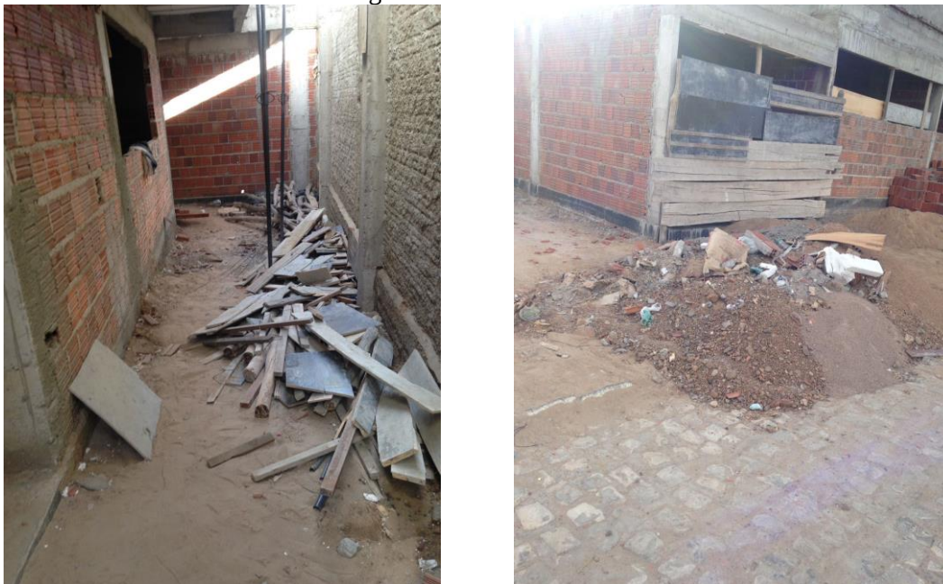
Figura 23 – Entulhos da obra
