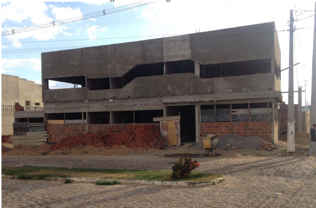
Figura 15 – Visão geral da obra B
