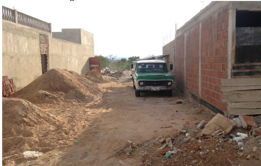
Figura 18 – Acesso de caminhão a obra
