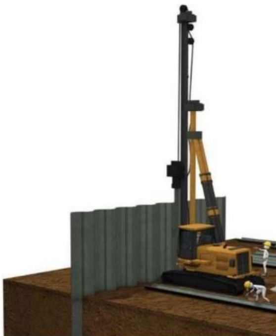
Figura 01 – Estacas-prancha metálica
