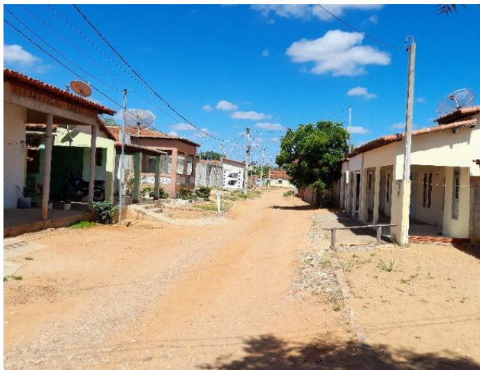
Figura 5 - Ruas não pavimentadas na comunidade de Linda Flor, Assu, RN.
