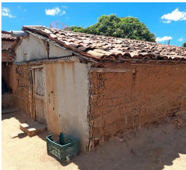
Figura 1 – Estrutura das primeiras residências localizadas na comunidade de Linda Flor, Assu, RN.
