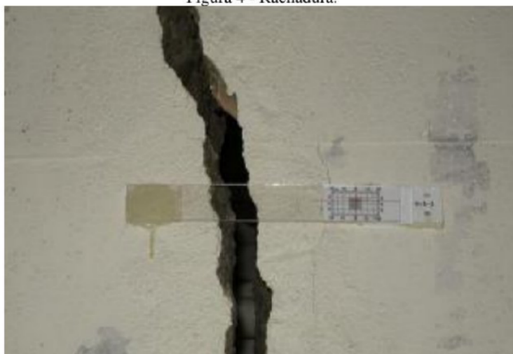
Figura 4 - Rachadura.
