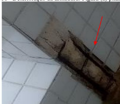
Figura 16 - Deterioração da armadura: Figura (a) pilar com revestimento cerâmico e Figura (b) pilar com reboco.
