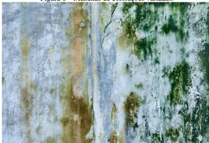
Figura 6 – Manchas de colorações variadas.
