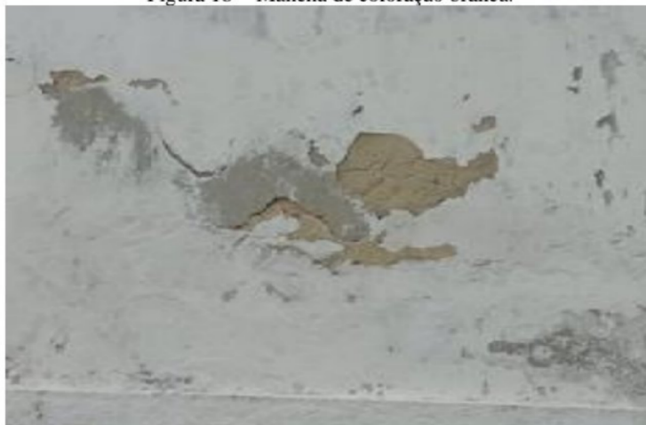
Figura 18 - Mancha de coloração branca.
