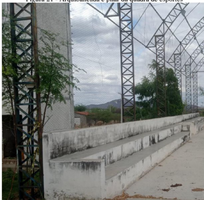
Figura 21 - Arquibancada e pilar da quadra de esportes
