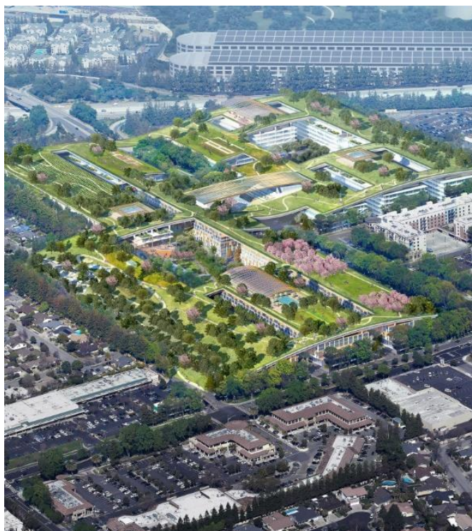
Figura 3: Projeto da maior cobertura vegetal no mundo
