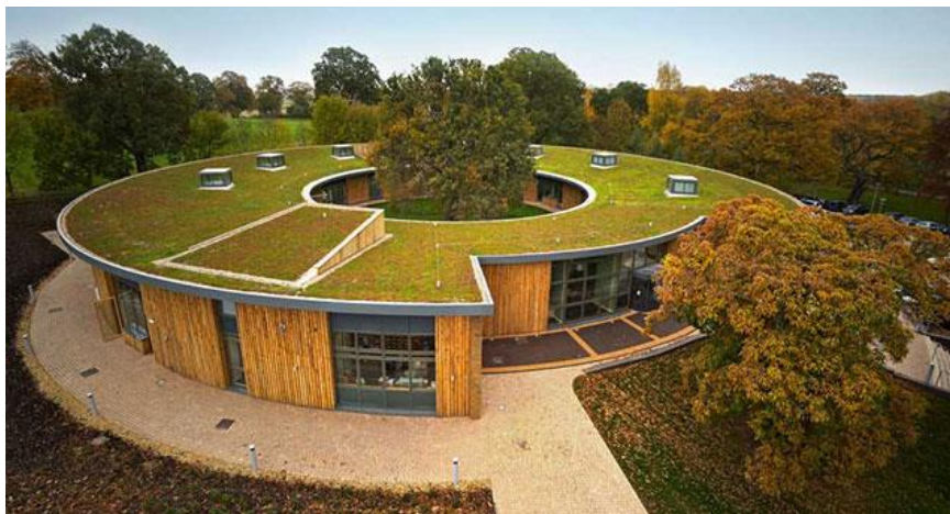
Figura 4: Telhado verde extensivo
