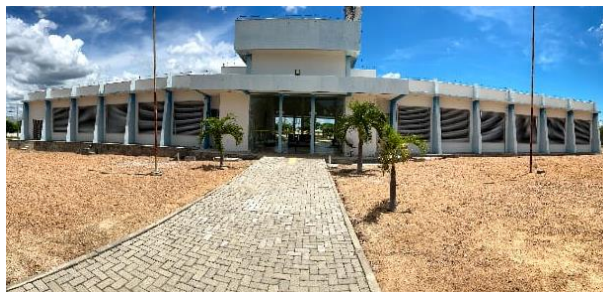
(a) Foto da fachada Sul do PACC
