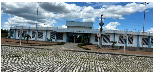
(c) Foto da fachada Norte do PACC
