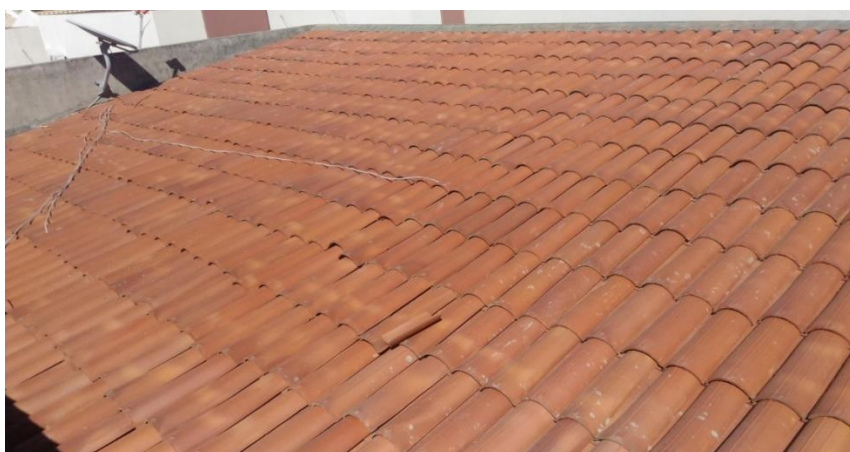
Figura 2. Telhado da unidade consumidora.
