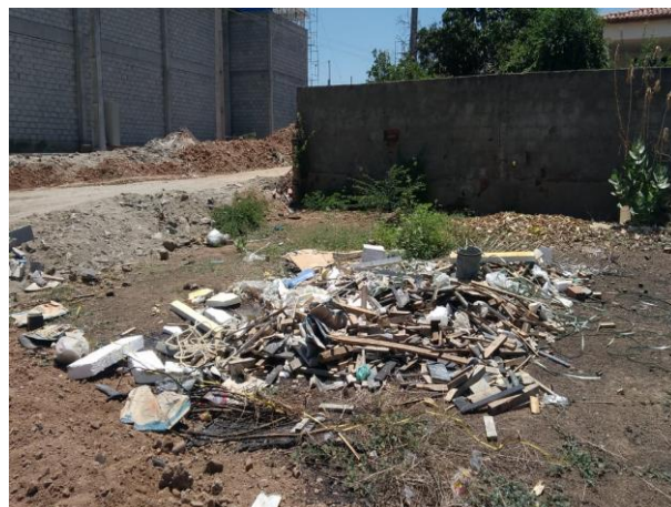
Figura 13 – Destino inadequado de resíduos sólidos da construção em Pau dos Ferros – RN, 2018.
