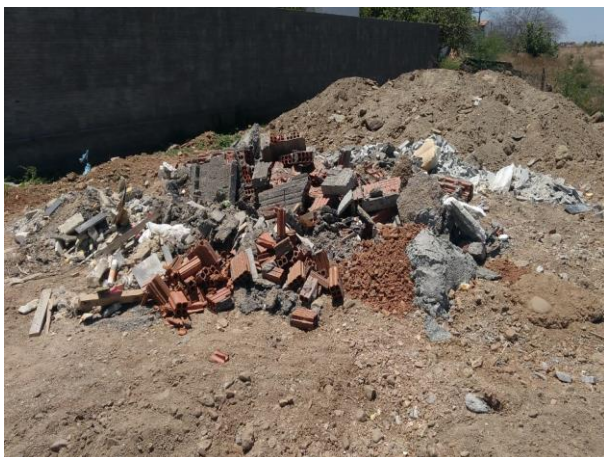
Figura 12 – Armazenamento inadequado de resíduos sólidos da construção em Pau dos Ferros – RN, 2018.
