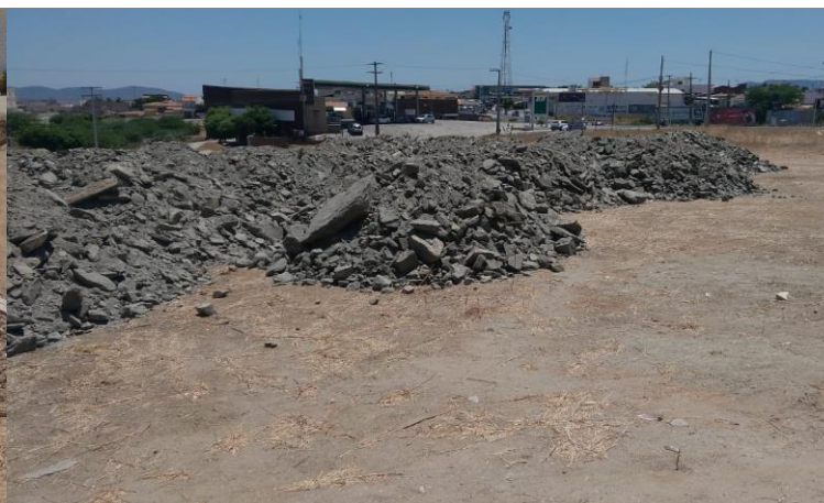
Figura 02 – Entulho sendo usado para aterro em Pau dos Ferros - RN, 2018.
