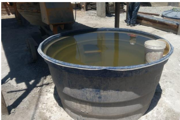
Figura 03 – Armazenamento de água para reuso em construtora de Pau dos Ferros - RN, 2018. Fonte: Autor, 2018.
