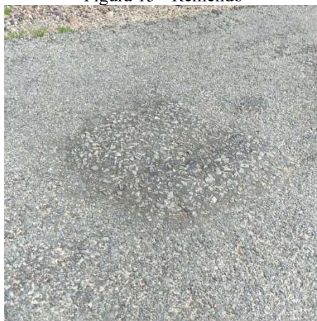
Figura 15 - Remendo
