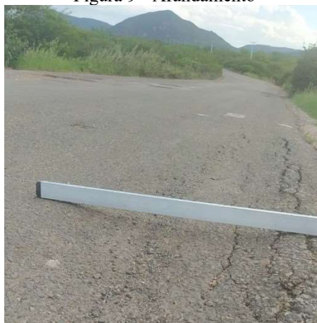
Figura 9 - Afundamento
