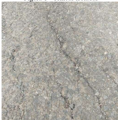
Figura 6 - Trincas isoladas
