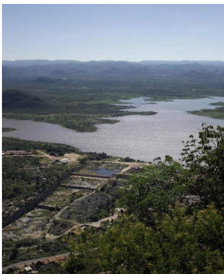
Figura 18 – Sangrador do açude Ministro João Alves (açude Boqueirão)
