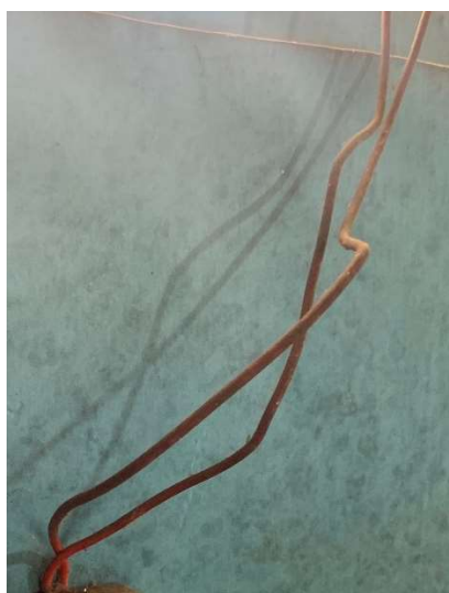
Figura 22 – Condutor exposto
