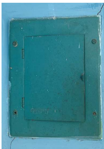
Figura 18 – QDG 1 Não Identificado
