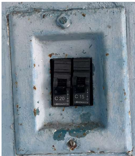
Figura 20 – Disjuntor
