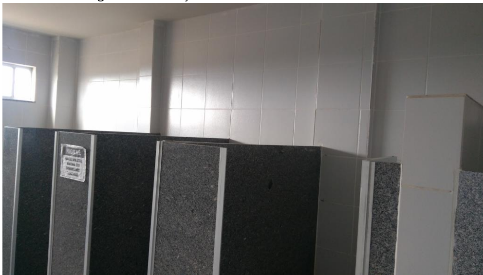
Figura 36 – execução do banheiro coletivo masculino térreo.
