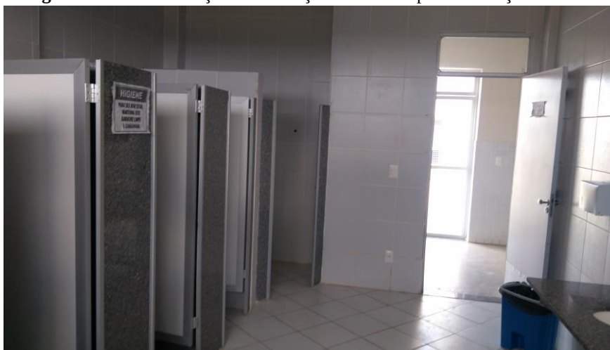
Figura 32 – Demonstração de tubulação embutida após a execução da obra.
