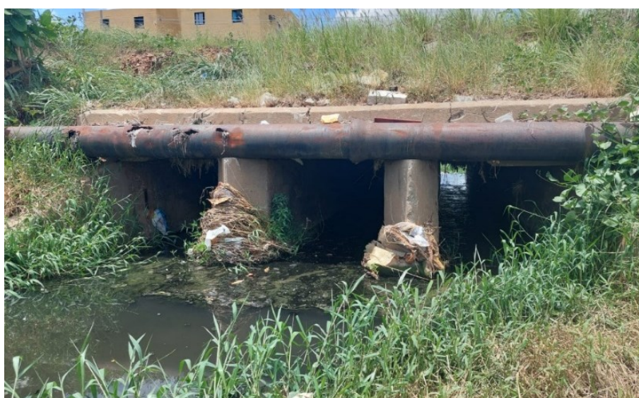
Figura 2: Bueiros que compõem o Sistema de Drenagem urbana na Av. Francisco Mota. Fonte: Autoria própria, 2023.
