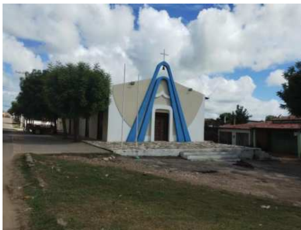
Figura 40: : Capela de Nossa Senhora Aparecida
