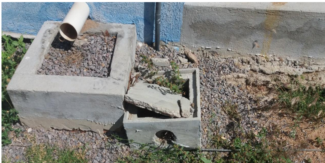
Figura 27: Caixa de Inspeção da Entrada da Edificação.
