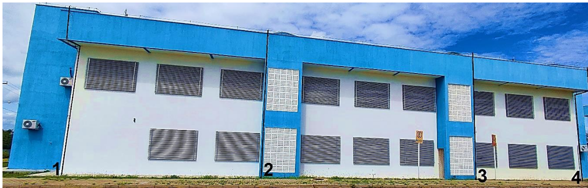
Figura 30: Subsistemas de Descidas Encontrados na Edificação.
