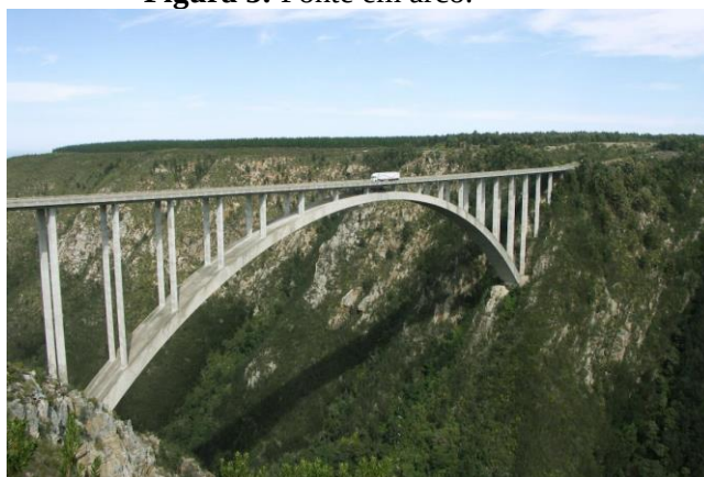
Figura 5: Ponte em arco.
