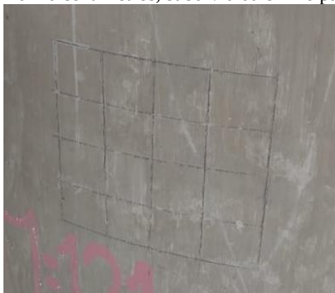
Figura 16: Malha de 20x20 centímetros, subdividida em 16 partições iguais.
