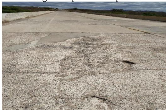
Figura 29: Desgaste superficial da pista de rolamento.
