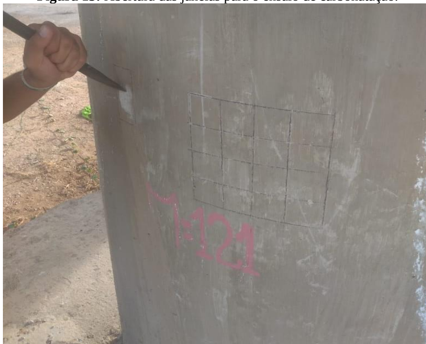
Figura 13: Abertura das janelas para o ensaio de carbonatação.
