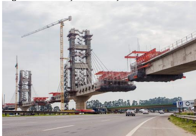
Figura 8: Construção em balanços sucessivos.
