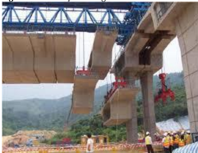
Figura 9: Construção em segmentos ou aduelas.
