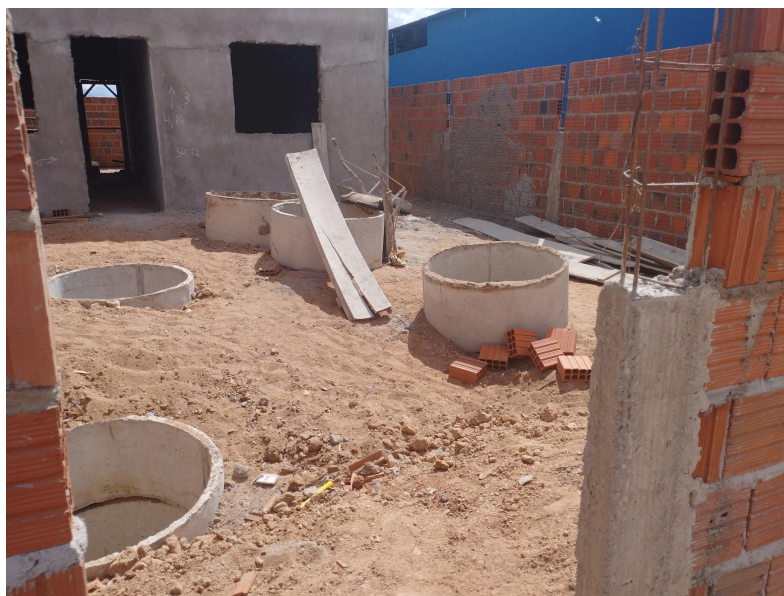
Figura 19 – Entulhos na obra
