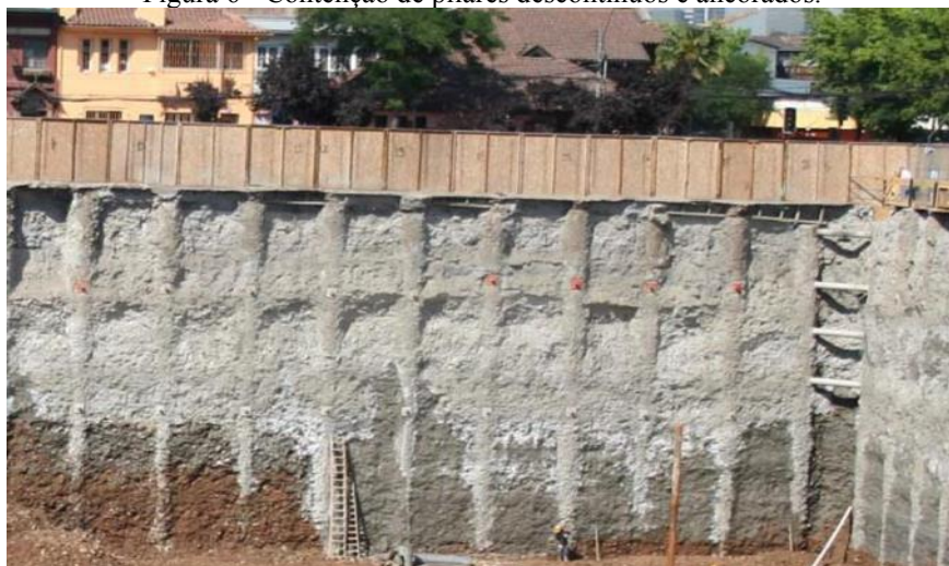
Figura 6 - Contenção de pilares descontínuos e ancorados.
