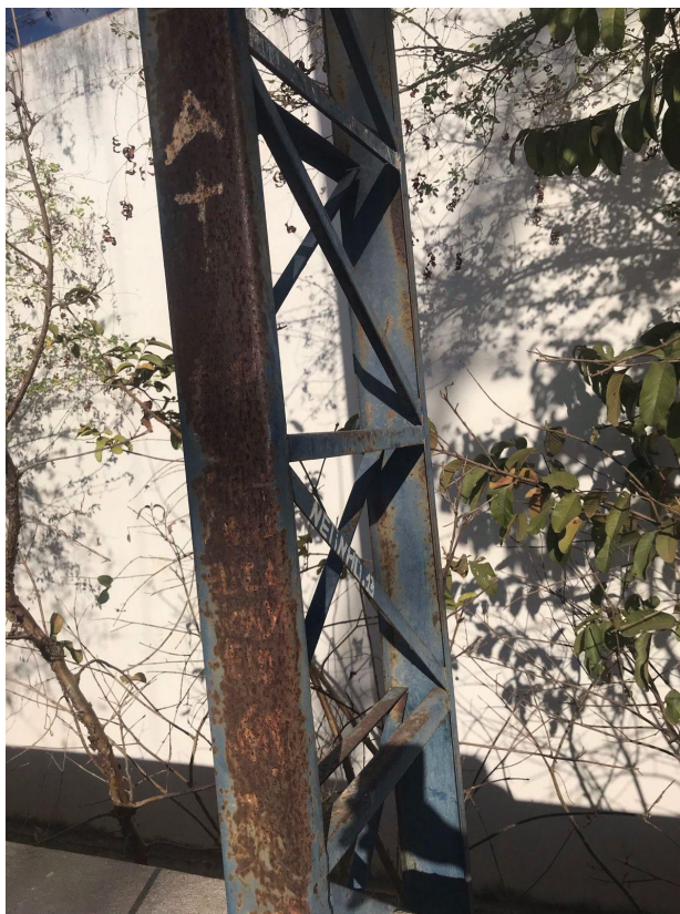
Figura 11: Pilar de sustentação A.
