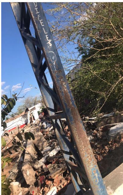
Figura 12: Pilar de sustentação B.
