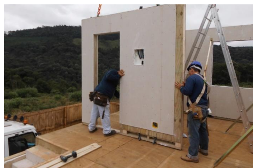
Figura 13. Posicionamento do painel de pré-fabricado de wood frame no local de montagem. DATec 040. (BRASIL, 2022)
