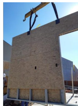
Figura 8. Movimentação para fixação de painel pré-fabricado de LSF no local de obra. DATec 041. (BRASIL, 2022)
