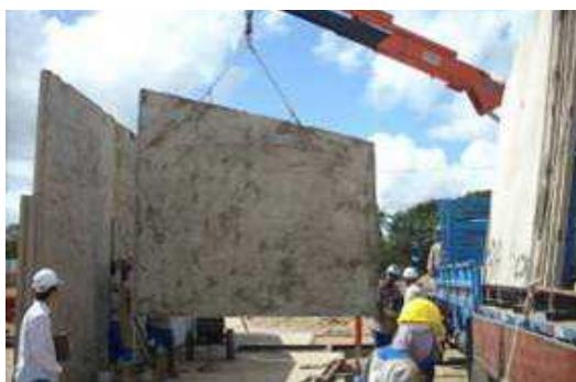
Figura 12. Içamento de painel pré-moldado de concreto para transporte ao local da obra. DATec 021-C. (BRASIL, 2022)
