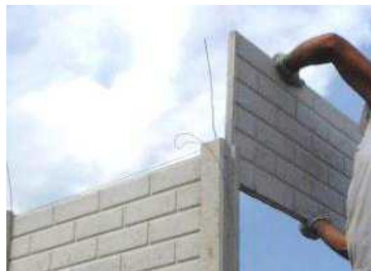
Figura 11. Assentamento dos painéis pré-fabricados de concreto. DATec 036-A. (BRASIL, 2022)
