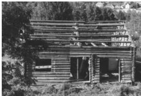
Figura 3. Casa de madeira sendo desmontada na Noruega. (KIBERT, CHINI E LANGUAGELL 2001)
