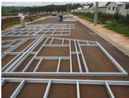
Figura 10. Montagem dos quadros estruturais de LSF. DATec 014 C. (BRASIL, 2022)
