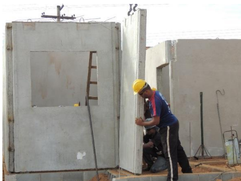
Figura 7. Estrutura de concreto pré-moldado sendo posicionada para assentamento na fundação da construção. DATec 043. (BRASIL, 2022)
