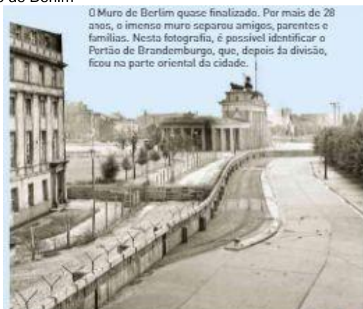
Figura 24: Muro de Berlim
