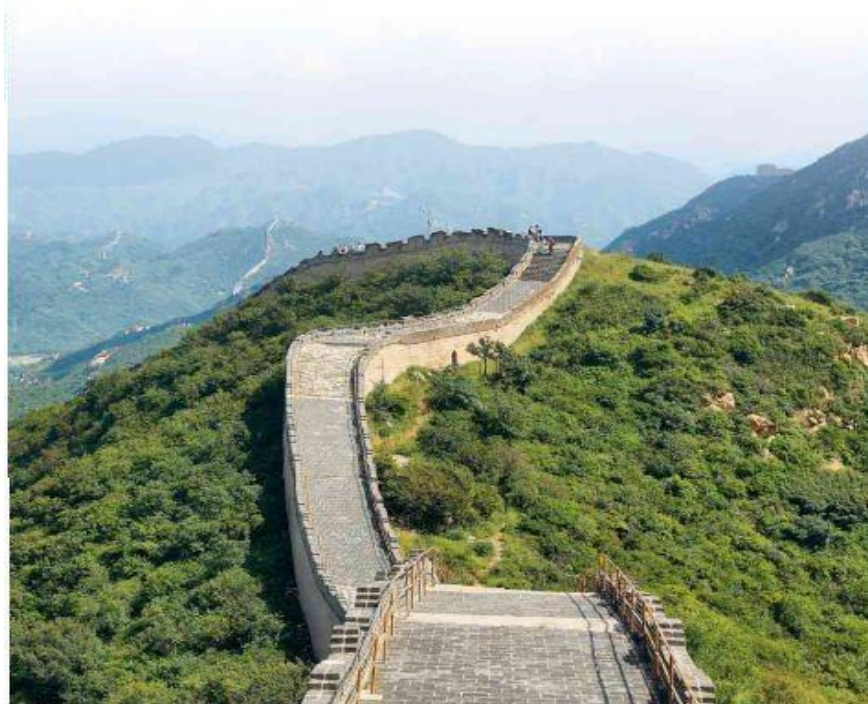
Figura 37: Muralha da China
