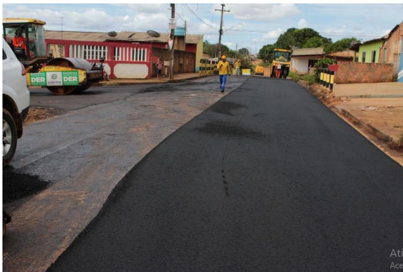
Figura 37 - Uma faixa de rolamento recapeada
