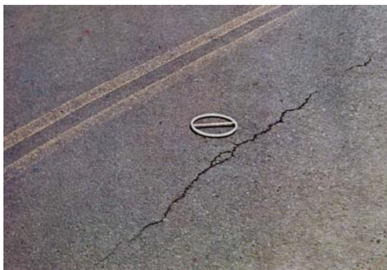
Figura 3 – Trinca longitudinal
