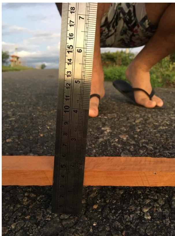
Figura 27 - Medição da profundidade da trilha de roda
