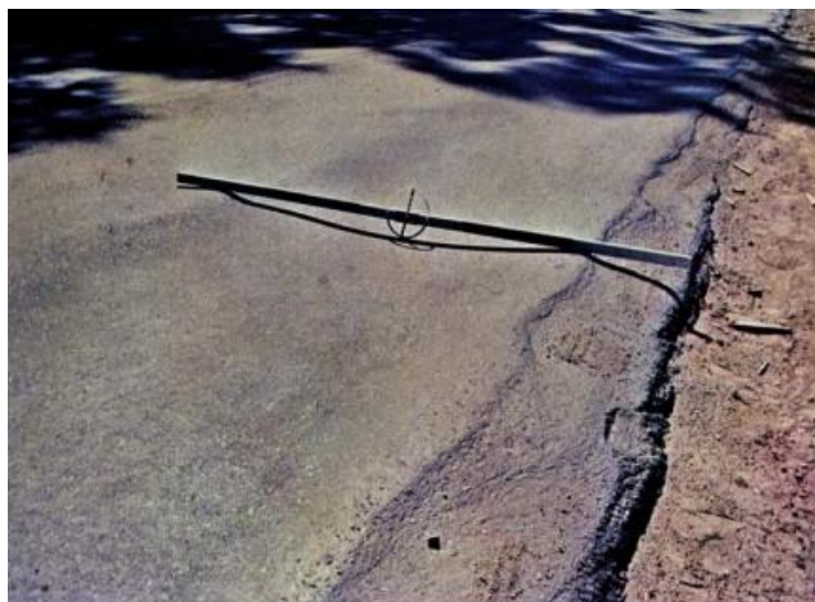
Figura 6 – Afundamento plástico
