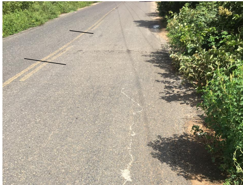
Figura 28 - Afundamento plástico
