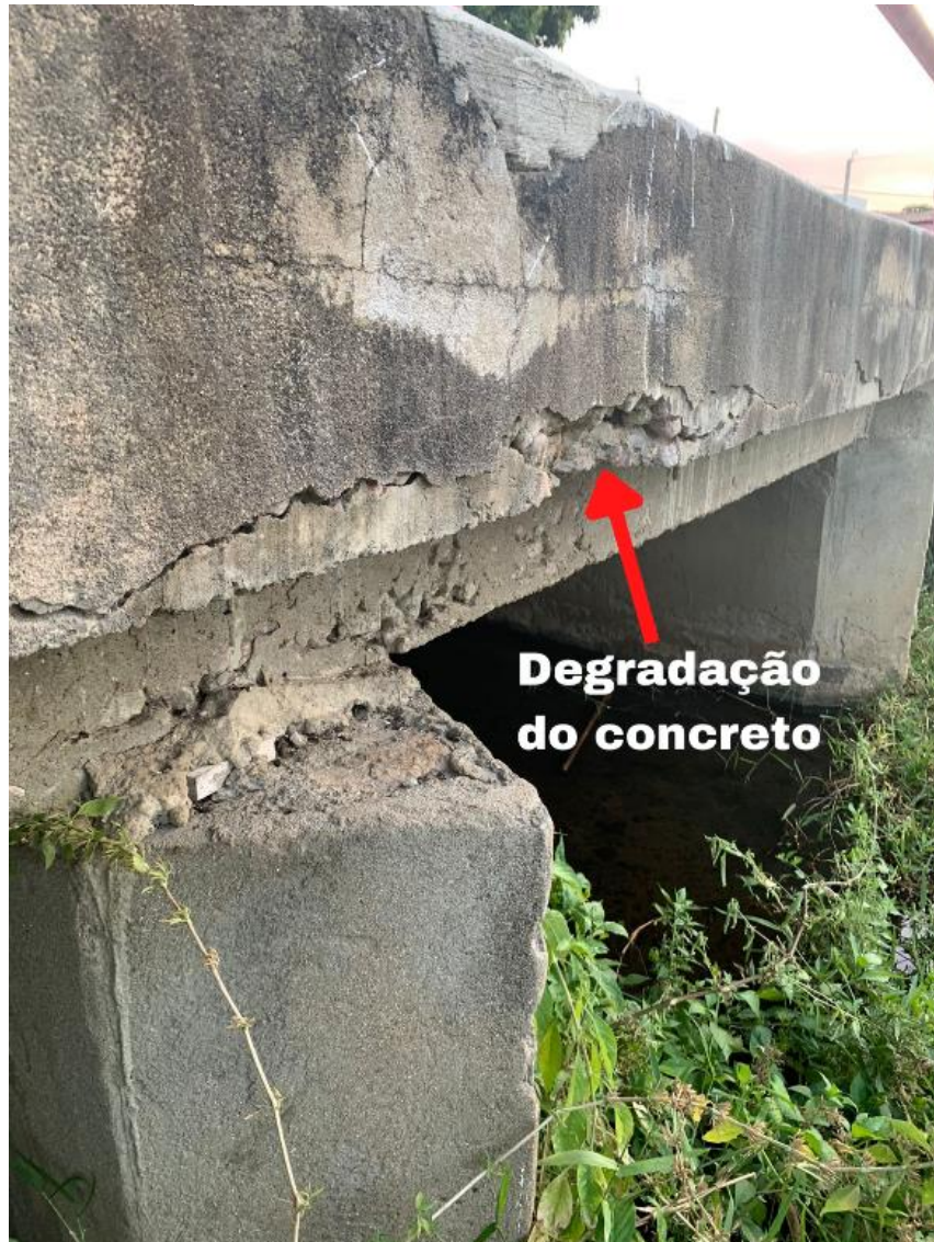
Figura 21 - Forte degradação.
