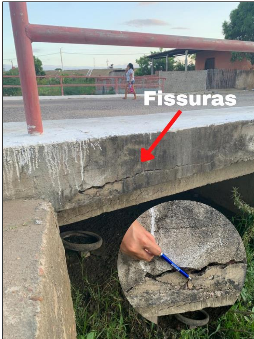
Figura 20 - Fissuras horizontais.
