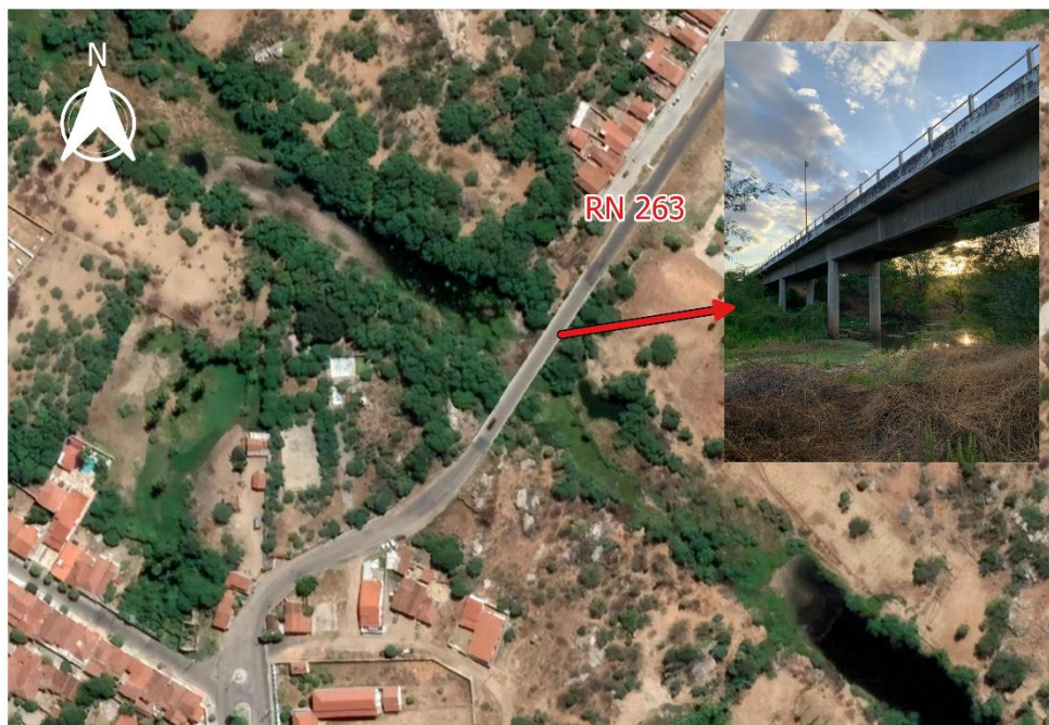
Figura 12 - Visão aérea da ponte.
