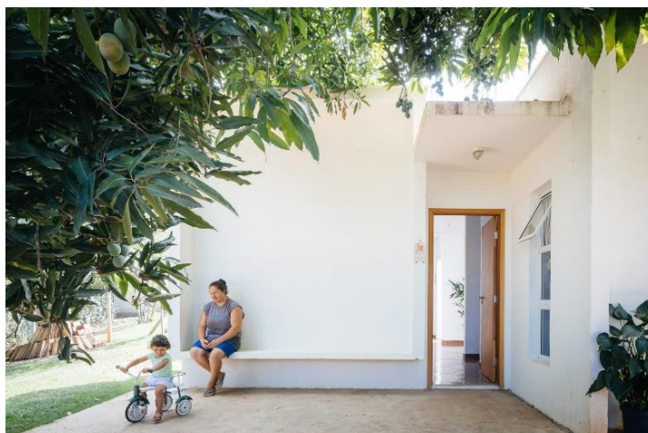
Figura 13 - Casa do caseiro - Recuo na fachada
