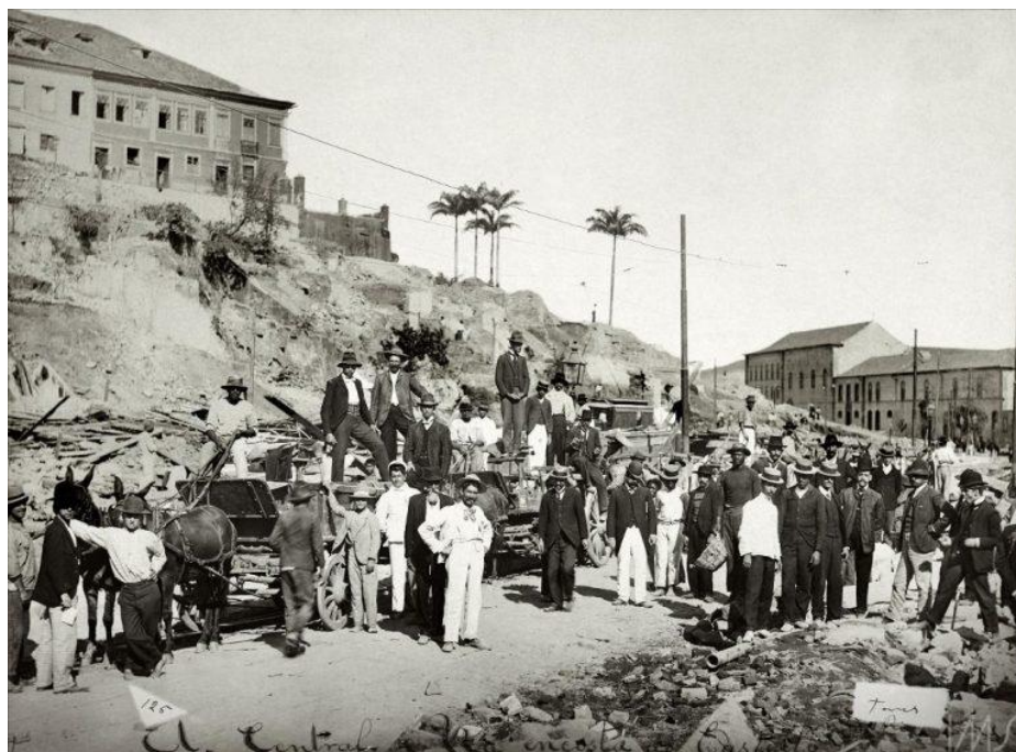
Figura 4 – Desmonte de parte do Morro do Castelo para a construção da av. Central, 1904
