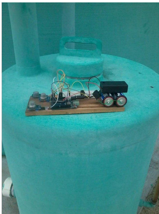
Figura 7: teste de detecção do gás metano na ETE
