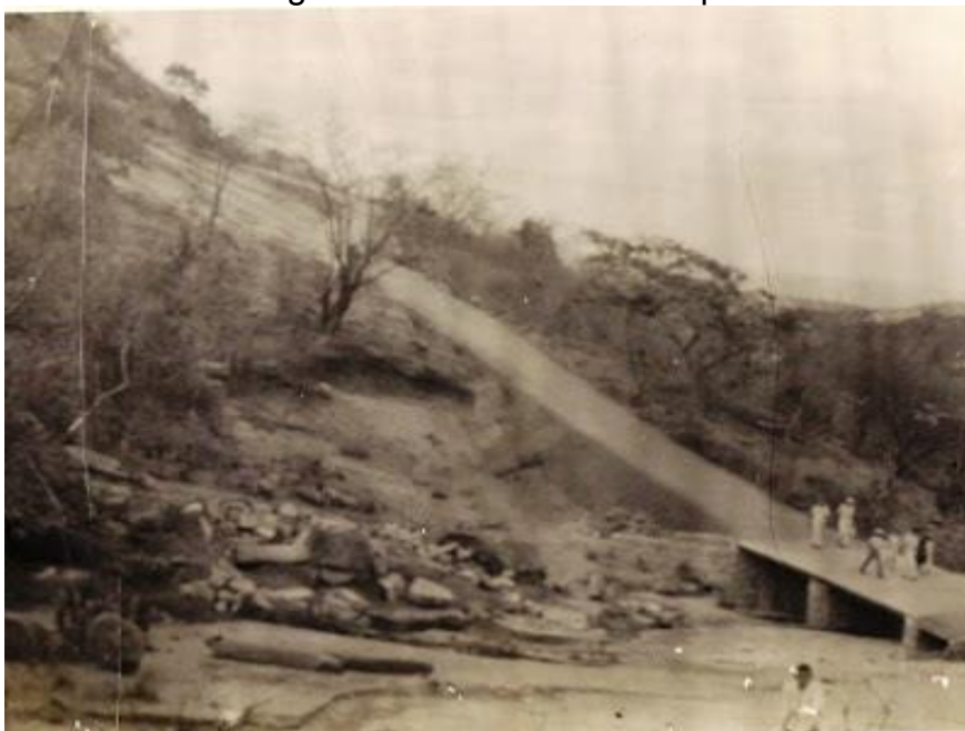
Foto 15: Antiga estrada – antes de ser pavimentada
